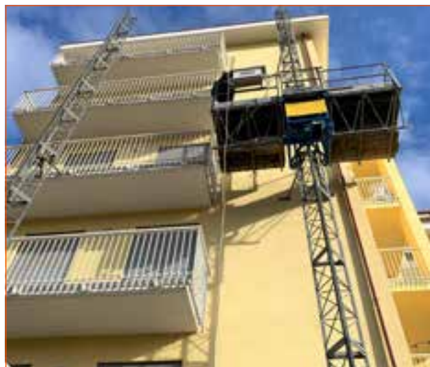
Utilizzo di ponte elettrico autosollevante a 1 colonna
