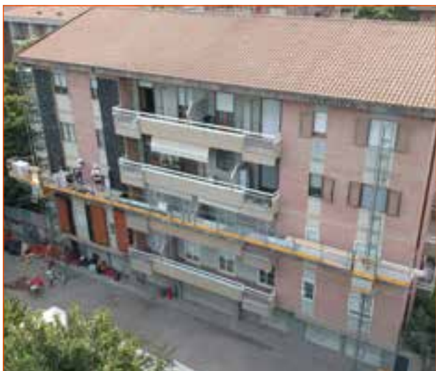
Utilizzo di ponte elettrico autosollevante a 2 colonne
