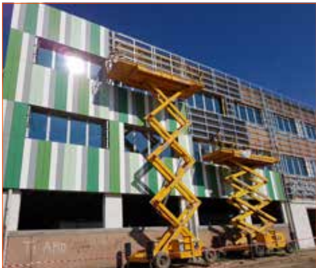
Utilizzo di piattaforme aeree semoventi
